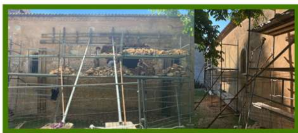
Travaux de sécurisation et de reconstruction du mur de la Chapelle de Saint-Maurice
